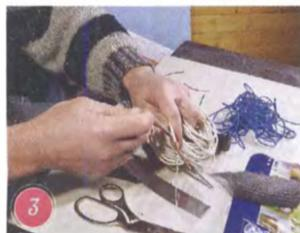
3 С толстого медного одножильного провода снимаем изоляцию.
