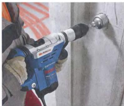
... или гнездо под выключатель при монтаже электропроводки.
