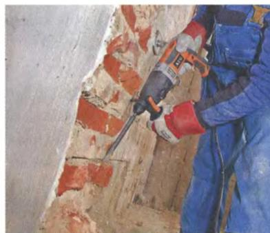
Этот инструмент незаменим, когда нужно снести кирпичную перегородку при перепланировке...
