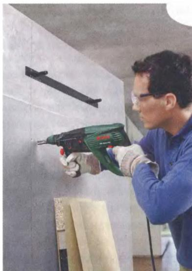
Перфоратор поможет, если предстоит повесить полки на стене из бетона...
